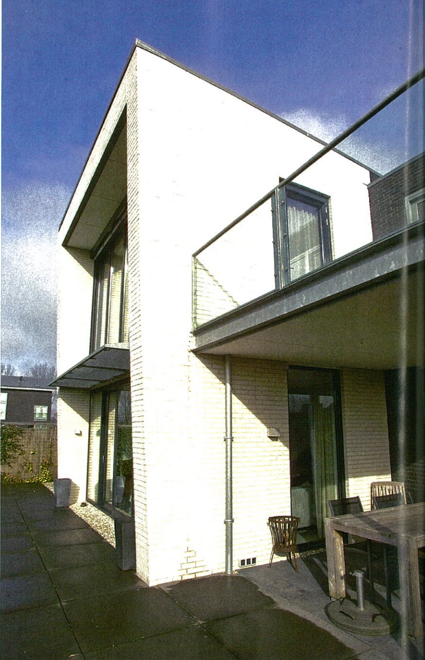
Het rooster boven de ramen van de begane grond zorgt er voor dat 's zomers de zon beperkt tot het huis wordt toegelaten. Eén van de voor- zieningen waardoor de temperatuur goed onder controle is te houden.
