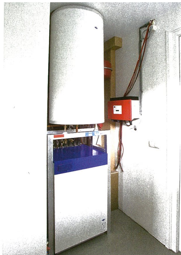
In de bijkeuken staat de techniek: onder de warmtepomp. Een leiding gaat tot 50 meter diepte en benut daar de warmte van het grondwater om het water voor de verwarmingsradiatoren voor te verwarmen. 's Zomers koelt het juist. Erboven de boiler die in verbinding staat met de zonnecollectoren.
