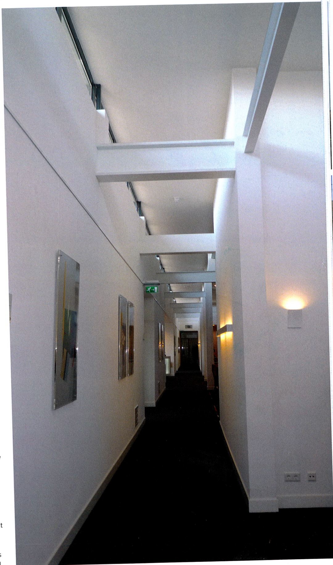
De bestaande staalconstructie is opgehoogd om een deel van het dak op te lichten voor extra daglichttoetreding.
