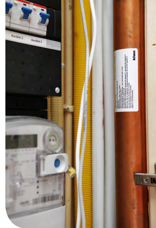
Standleiding van de warmwaterwinning in de meterkast
